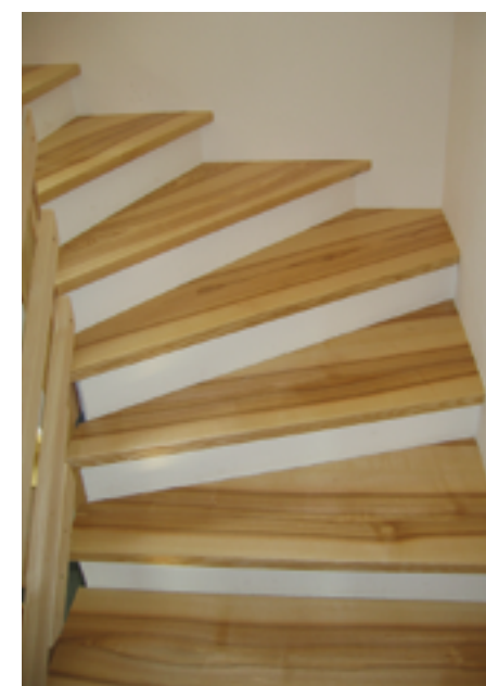
Treppe aus Balzner Eschenholz, hergestellt von der Anton Vogt Schreinerei AG.
