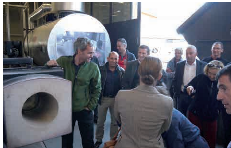
Gerhard Wille (links) bei einer Führung durch das Heizhaus.
