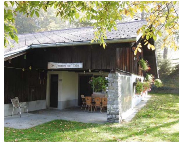
Das heutige Alpgebäude entstand 1957 nach Plänen von Franz Vogt. Als Betriebsnachfolger seines Vaters Basil Vogt führte er auch die Zimmermannsarbeiten aus.
