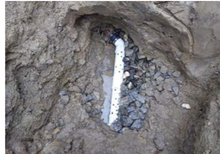
Links: Freigelegte Quelfassung. Mitte: Sanierte Quelfassung.
