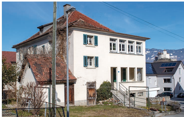
Zweifamilienhaus mit Garagen, Prär 6.
