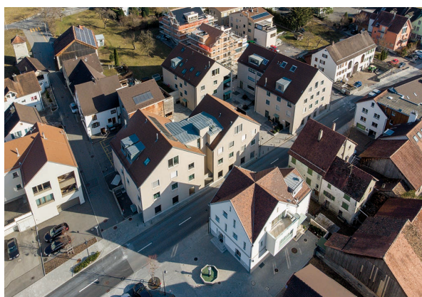
Überbauung Höfle, Haus Nrn. 32, 34, 36, 38:
