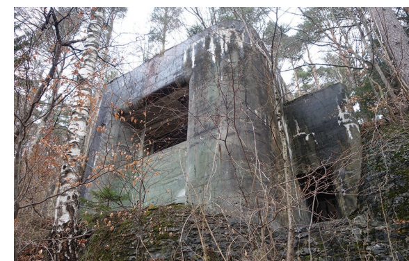
Bunkeranlagen, Fläscher Gemeindegebiet.
