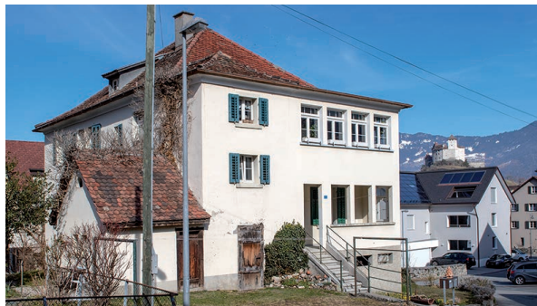
Zweifamilienhaus mit Garagen, Prär 6.
