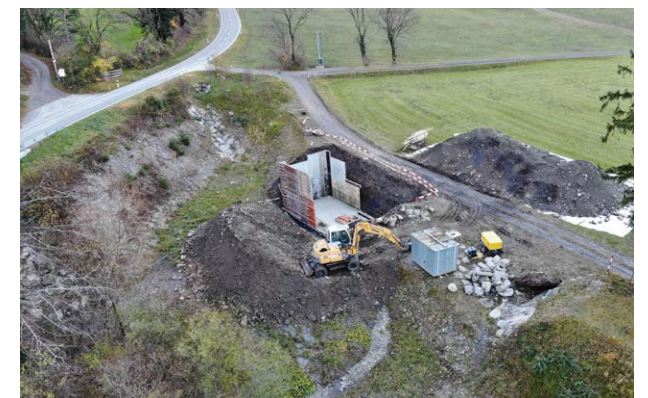
Im Gebiet And entsteht ein Löschwasserbecken mit einem Fassungsvermögen von circa 250'000 Litern.
