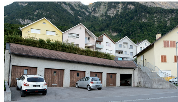
Reihengaragen und Zivilschutzanlage, Palduinstrasse.
