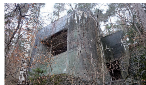
Bunkeranlagen, Fläscher Gemeindegebiet.
