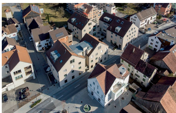
Überbauung Höfle, Haus Nrn. 32, 34, 36, 38:
