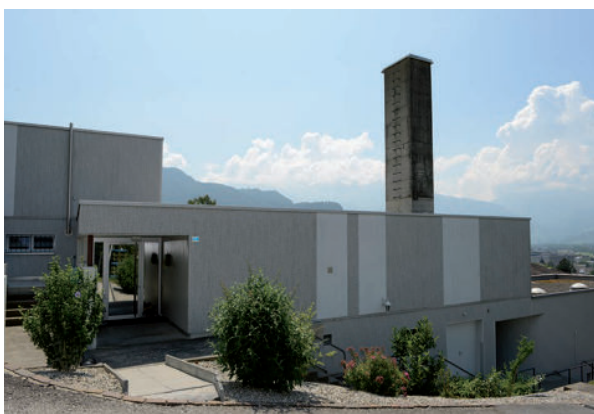
Terrassensiedlung Ramschwagweg, Ramschwagweg 51: drei 2½-Zimmer-Wohnungen.
