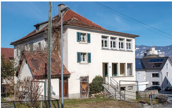
Zweifamilienhaus mit Garagen, Prär 6.
