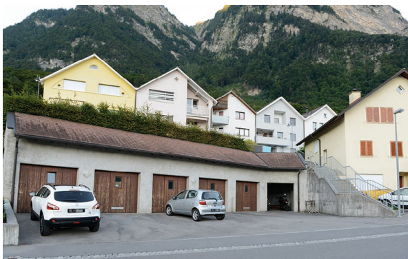
Reihengaragen und Zivilschutzanlage, Palduinstrasse.
