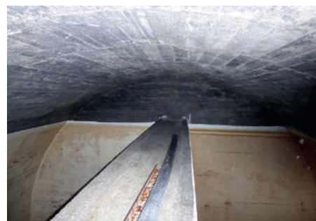
Oben: Rohbau des neuen Reservoirs, Herbst 2023.
