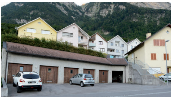
Reihengaragen und Zivilschutzanlage, Palduinstrasse.
