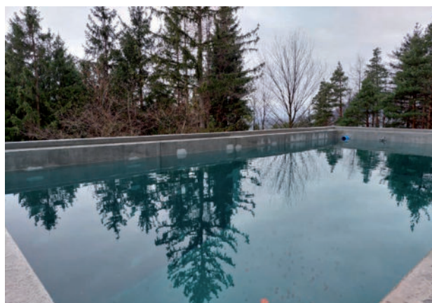
Löschwasserbecken Alte Antenne.
